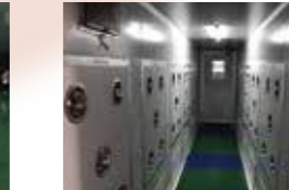
クリーンルーム入り口(エアシャワー室)
